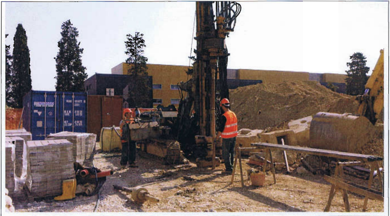
Sondaggio a carotaggio
