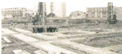
Completamento delle fondazioni della Sede Centrale
