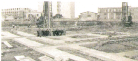
Completamento delle fondazioni della Sede Centrale
